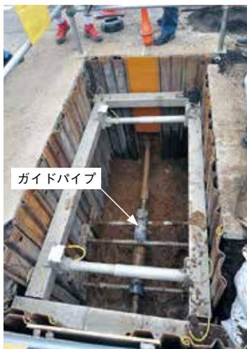
写真-4 発進坑のガイドパイプ設置状況
