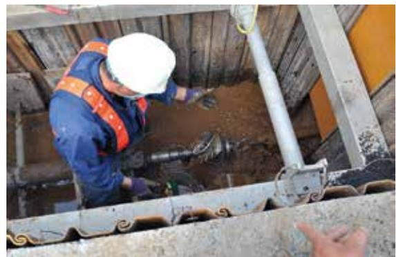
写真-9 プレリーミングのバックリーマ到達状況（発進坑）
