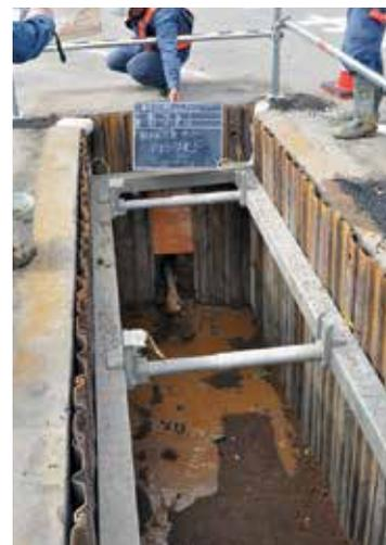
写真-7 ドリルヘッドの到達状況(到達坑)
