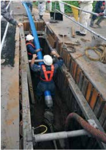
写真-10 埋設管引込開始状況
