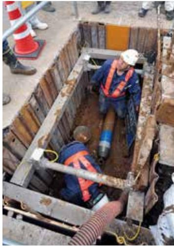
写真-11 埋設管到達状況
