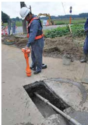
写真-3 貫入口から発進坑に向けたアプローチ削孔工
