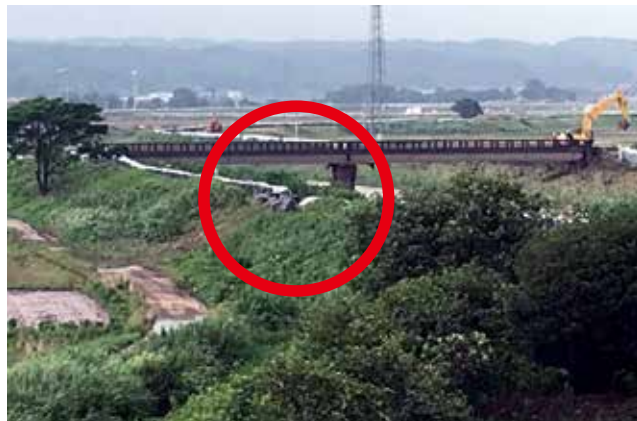
写真-6 大雨による木山川大型土囊流出箇所 (センターより約100m上流)
