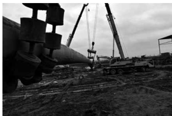
写真-1 如東-海門-崇明島間の揚子江を潜るガス輸送管施工状況
