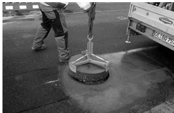
写真-6 円形にくり抜かれた舗装
