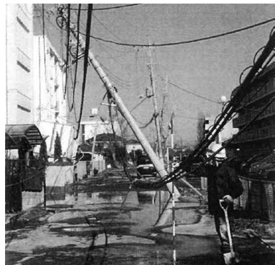
写真-1 地震による電柱倒壊（香取市） [道路建設No.750号より]
