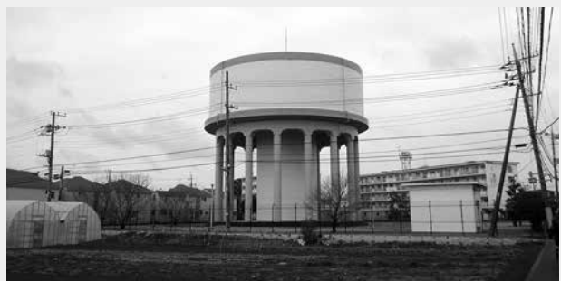
船橋高架水槽
