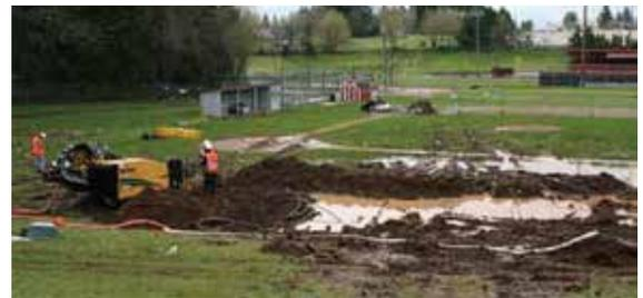
写真-6 サンディ高校での地中熱交換器設置工事 (ISCO INDUSTRIES reportより抜粋)
