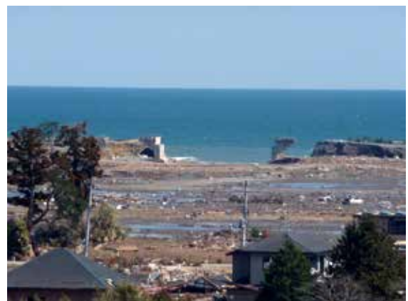
写真-5 津波被害を受けた湾岸道路の橋梁部
