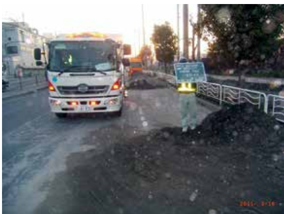
写真-1 震災直後、江東区の液状化地域での空洞調査
