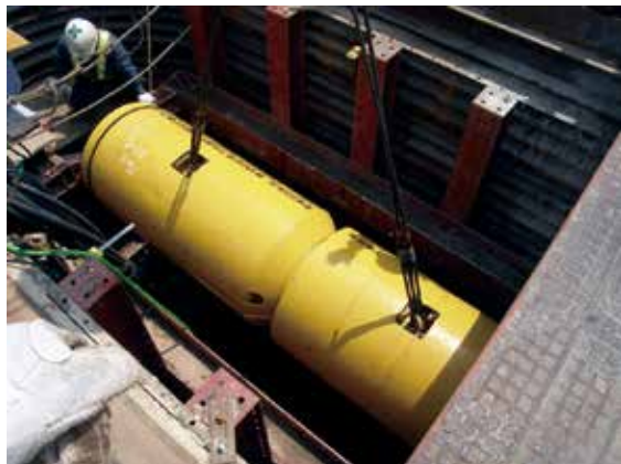
写真-4 災害復旧の改築推進施工状況
