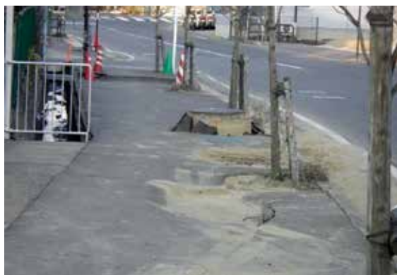
写真-1 人孔浮上りと周辺地盤沈下
