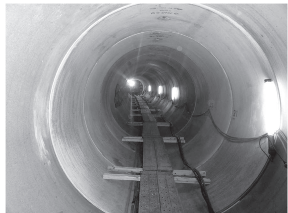
写真-2 呼び径2600推進管内状況
