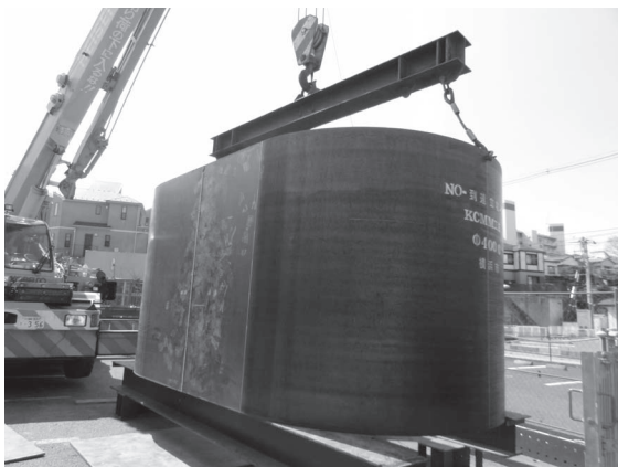
写真-1 小判形で搬入されたケーシング立坑
