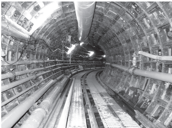
写真-1 シールドR=18m急曲線部
