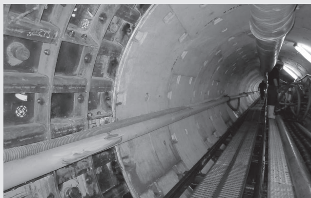
▲ シールドR=18m急曲線部(左), 推進管とセグメントの切り替わり部(右)
