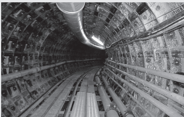
▲ シールドR=18m急曲線部(左), 推進管とセグメントの切り替わり部(右)
