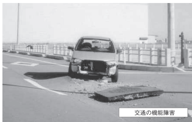
写真-2 マンホール浮上現象による被害②
