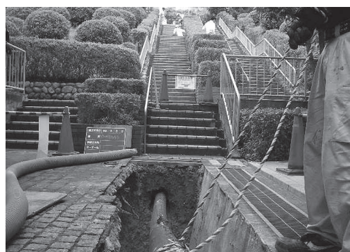
施工状況（階段部施工φ150×33m）
