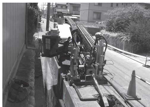
HDD工法用ドリル（バーミアD22×20）
