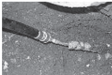
写真-4 PE管接続状況
