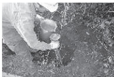
写真-3 充填材注入状況
