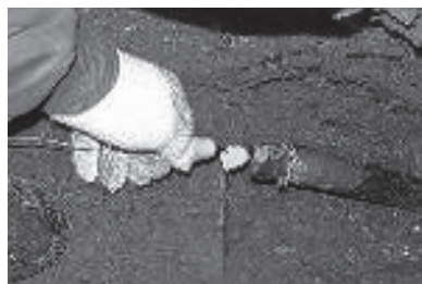
写真-2 通線状況
