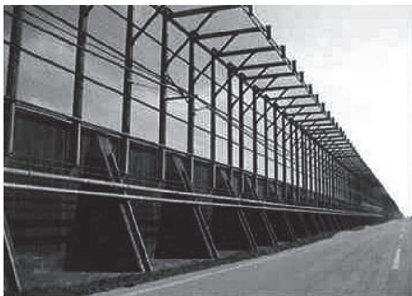
写真-1 飛散防止用フェンス
