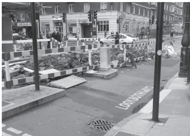
写真－1 ロンドンでの道路を使用した工事の状況（2008年4月）
