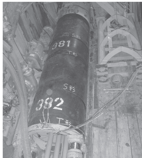
写真-3 2連中押管推進状況
