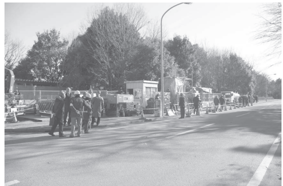
写真-3 敷地も広く、交通量もほとんどありませんが、地下で錯綜するパイプを破損しないためと、樹木を守るために非開削工法が採用されました
