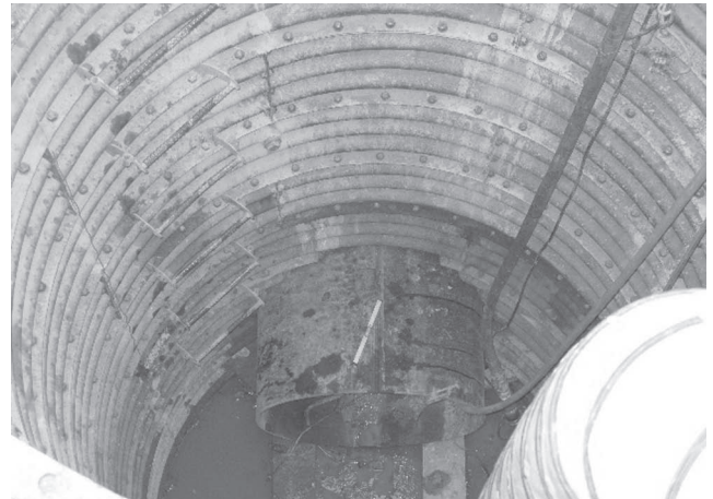
写真-10 残置物件を除去するための鋼管推進
