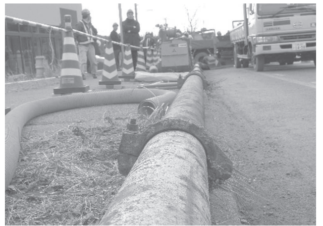
写真-12 改築推進を可能としたバイパスシステム
