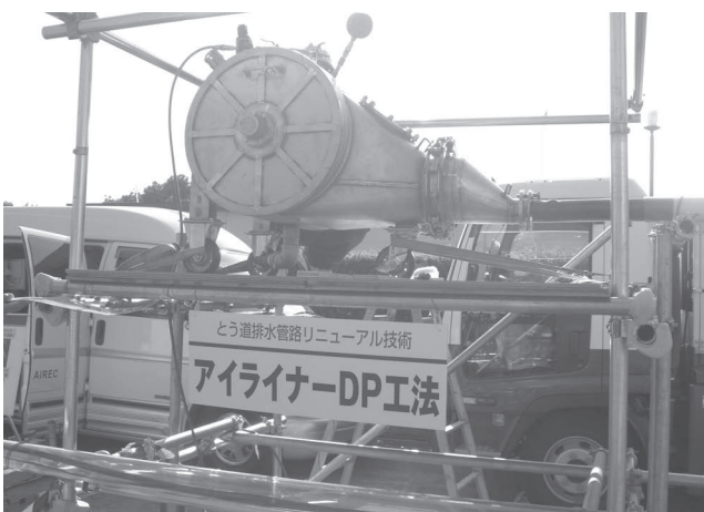
写真-4 アイライナー DP工法
