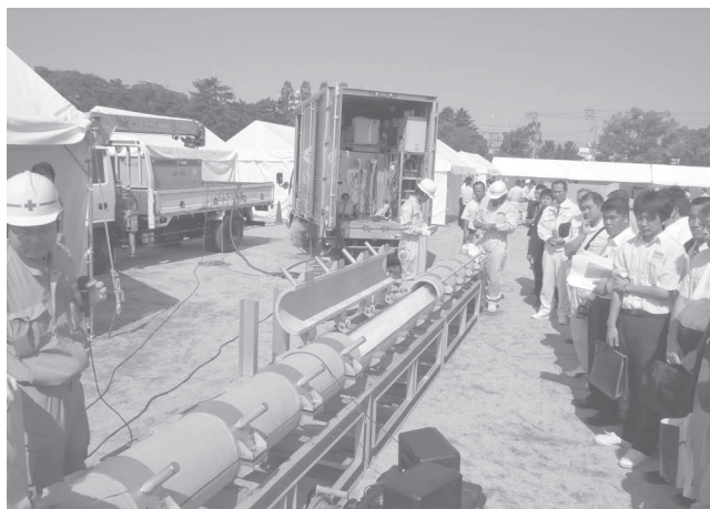
写真-7 既設管の中の様子も見られます
