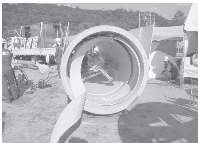
写真-9 製管の様子がよく分かります
