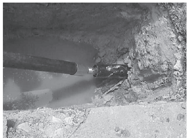
シンガポールのパイプバースティング工事
