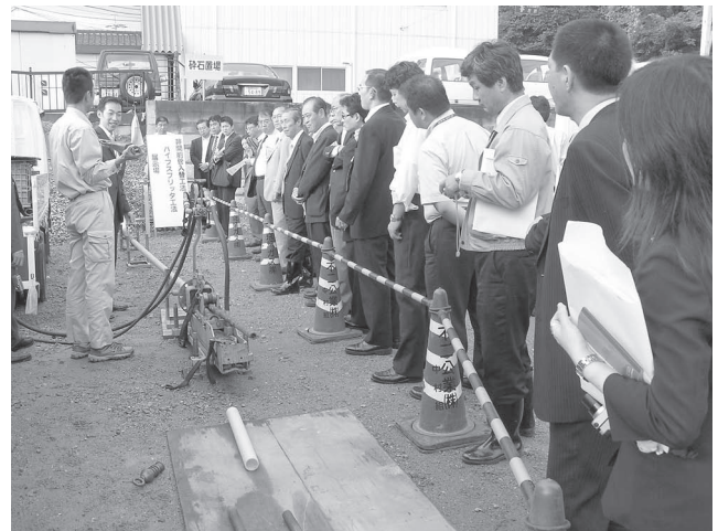
写真-4 パイププリッター概要説明
