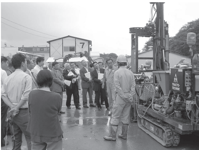
写真-5 グルンドピットコンパクト概要説明
