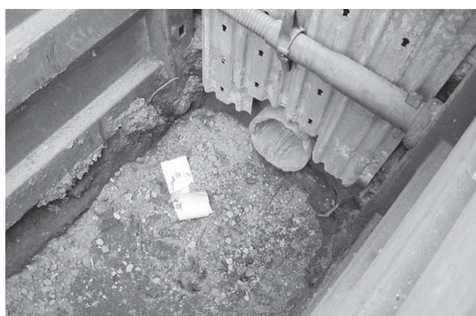
写真－2 発進側（破碎機挿入側）の立坑状況
