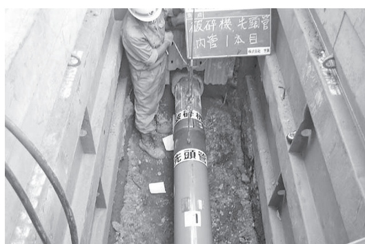
写真－5 破碎機本体及び塩ビ管接続状況
