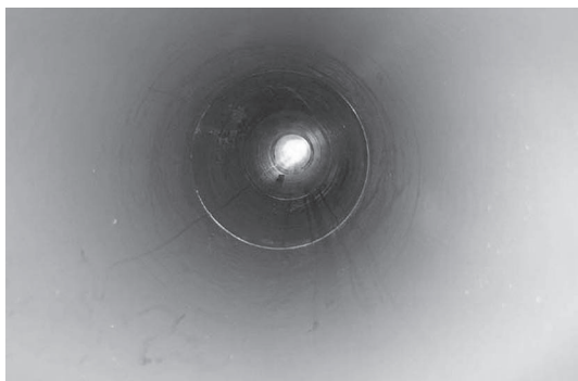
写真ー10 新管内部状況
