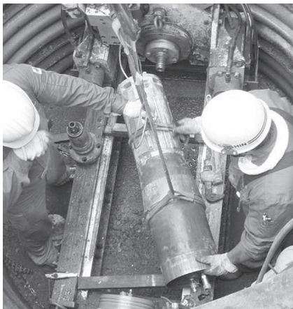
写真ー9 破碎機本体回収状況
