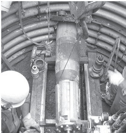
写真ー8 破碎機本体及び更新管到達状況
