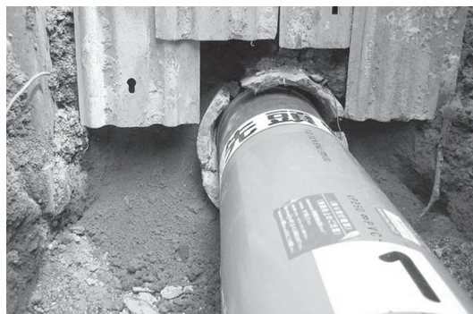
写真－6 破碎及び引込開始状況
