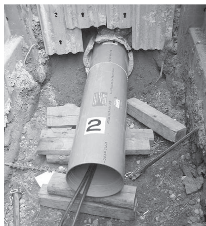
写真－7 更新管更新状況
