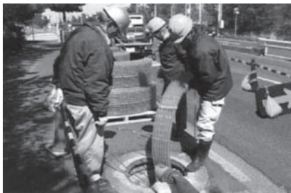
写真-1 マンホールから3Sセグメントを投入
