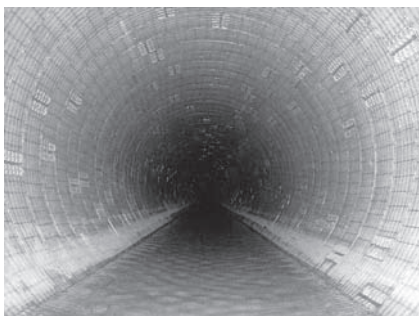
写真-2 施工後の状況
