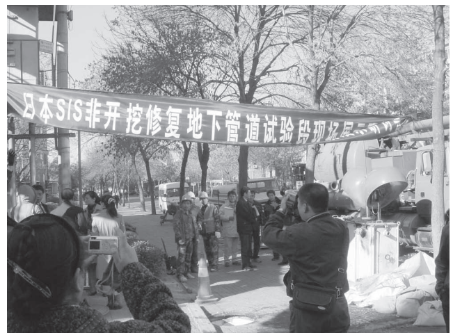
デモ施工現場の様子
