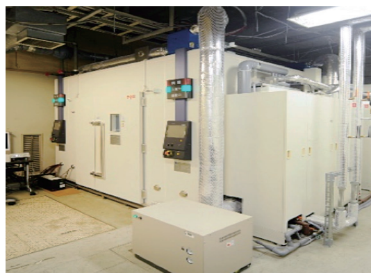
写真-5 環境実験棟(恒温・恒湿室)
