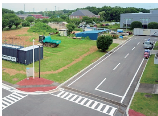
写真-12 屋外実験ヤード
