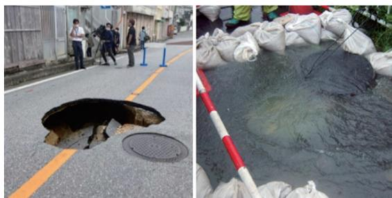
写真-1 道路陥没と溢水
