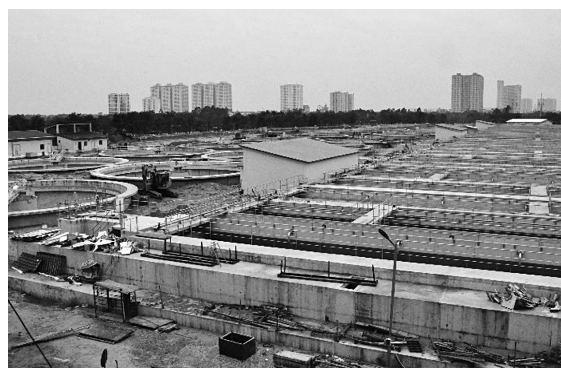
写真-4 エンサ下水道整備事業・処理場建設現場／ JFEエンジニアリング(株)
