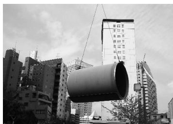
鋼管の吊り降ろし
