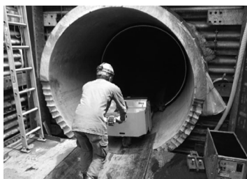
既設管内運搬
