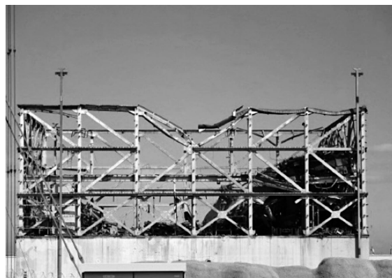
写真－5 1号機原子炉建屋
