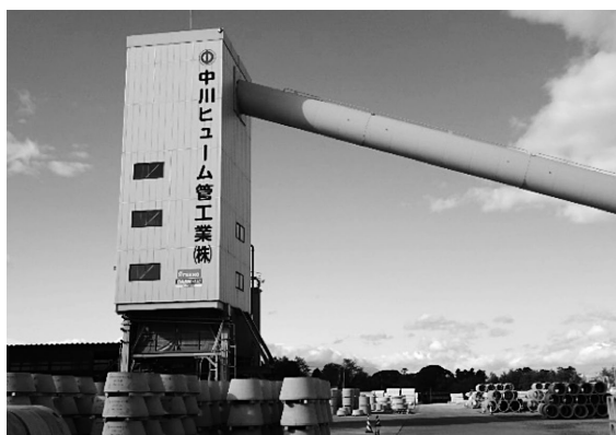
写真-19 コンクリート製造プラント
