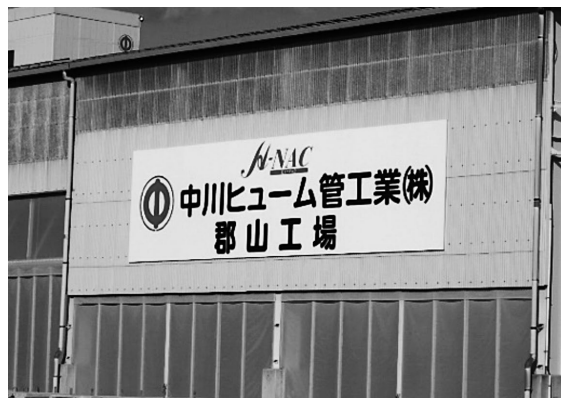
写真－13 工場建屋
