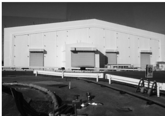
写真－7 多核種除去設備（ALPS）
