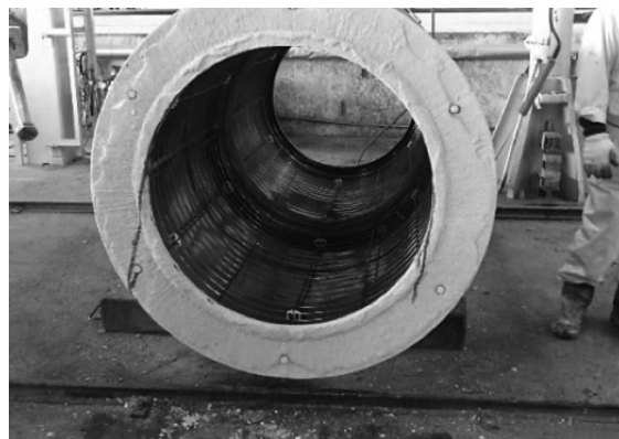
写真－17 型枠内に鉄筋を設置した様子
