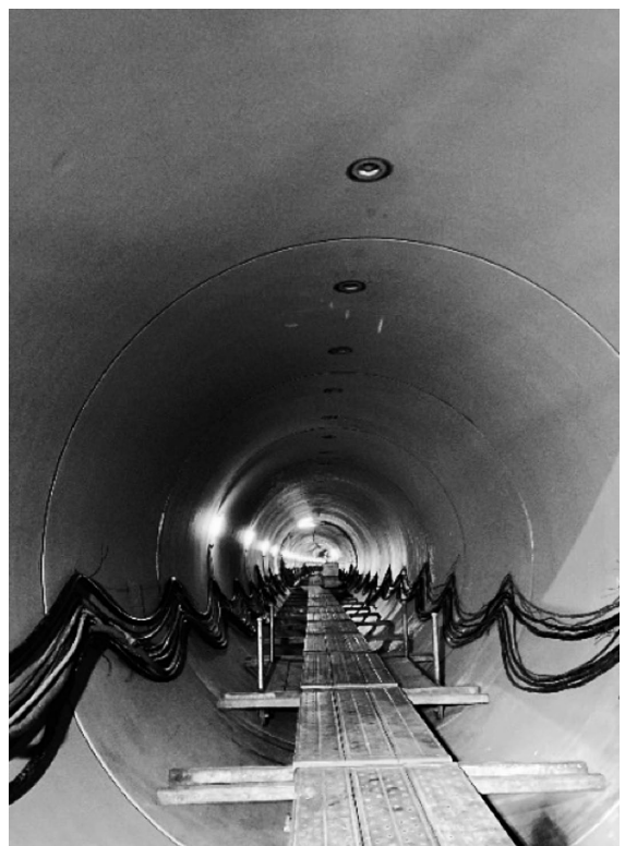
写真-10 推進管内状況
