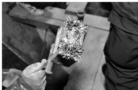
写真-6 切削された金属支障物
