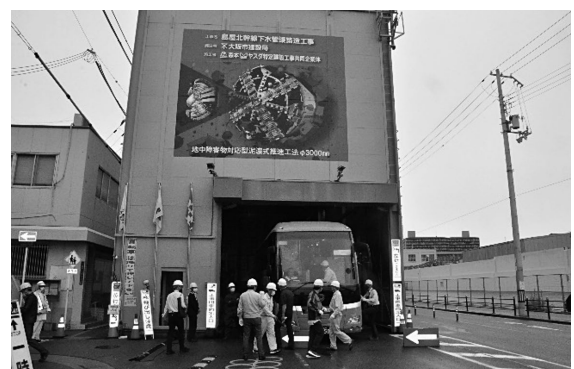
写真-3 発進基地となる防音ハウス
