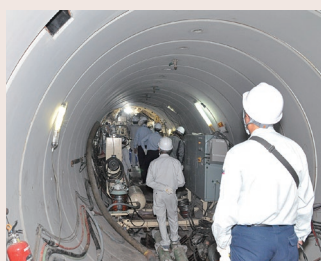
▲ 掘進状況の見学
