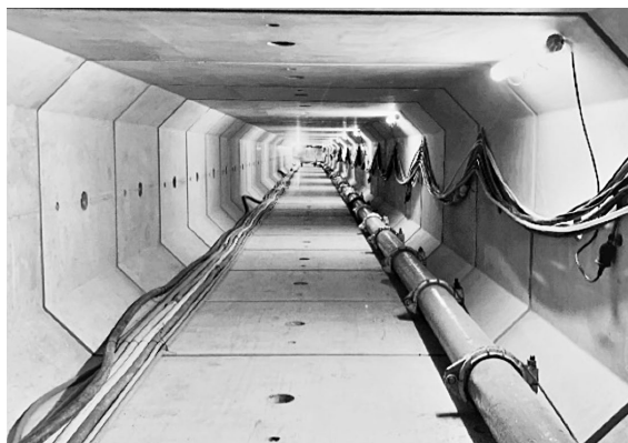
写真-2 完成函体内の状況
