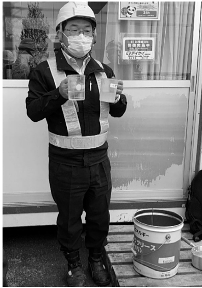
写真-4 2液性固結型滑材の混合実演
