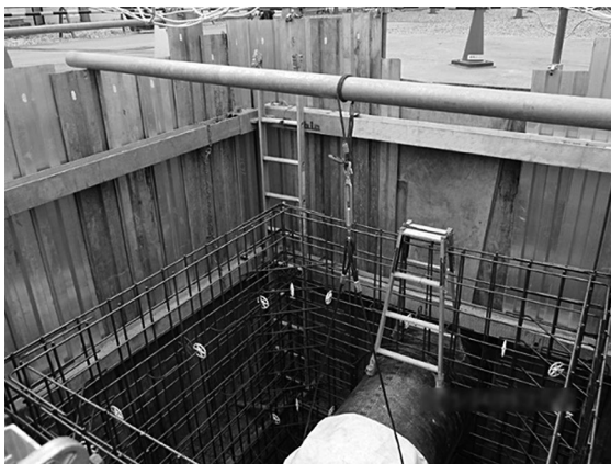
ホーシン簡易土留め工法の施工例
