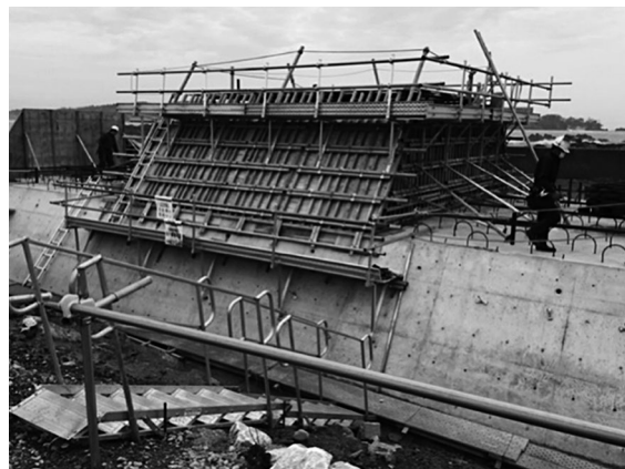
ホーシン型枠工法の施工例
