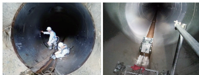
写真-2 従来の点検手法 (左: ロープ高所作業, 右: 点検ロボット)
