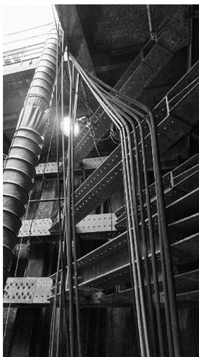
写真-4 複数の注入材を輸送するチューブ
