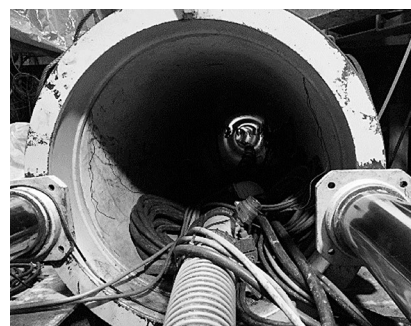
写真-5 発進立坑からの掘進方向側の様子
