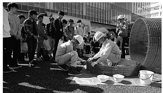
分割されているセグメント材を既設管内で円形に組み立てる
