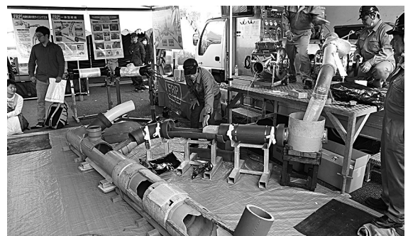
収納ドラムから押し出されたライナーが既設ますを通過する様子
