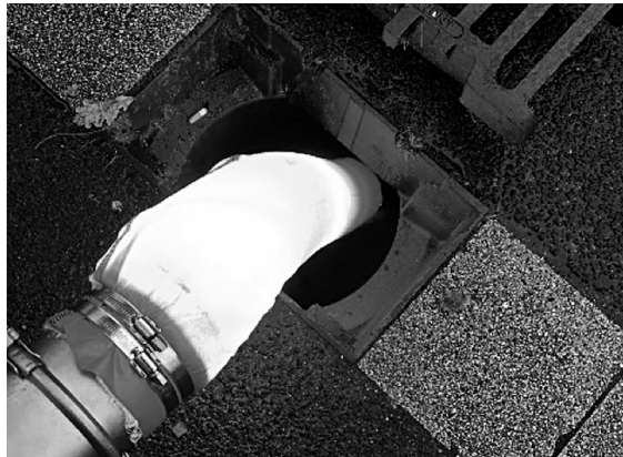
写真-1 取付管用LEDライト硬化工法
