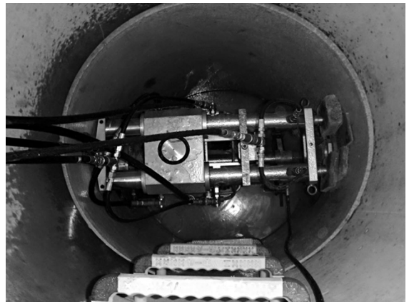
▲ 切削機設置状況
