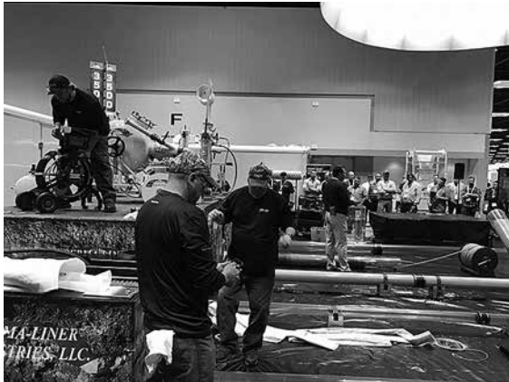
写真-7 反転工法の実演状況
