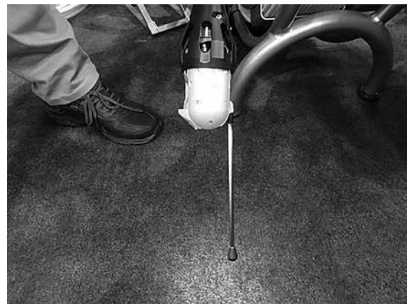
写真-5 ガイドスティックで取付管への挿入性を向上
