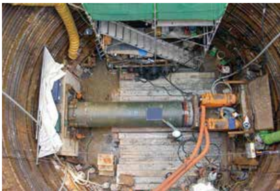
写真-5 施工状況
