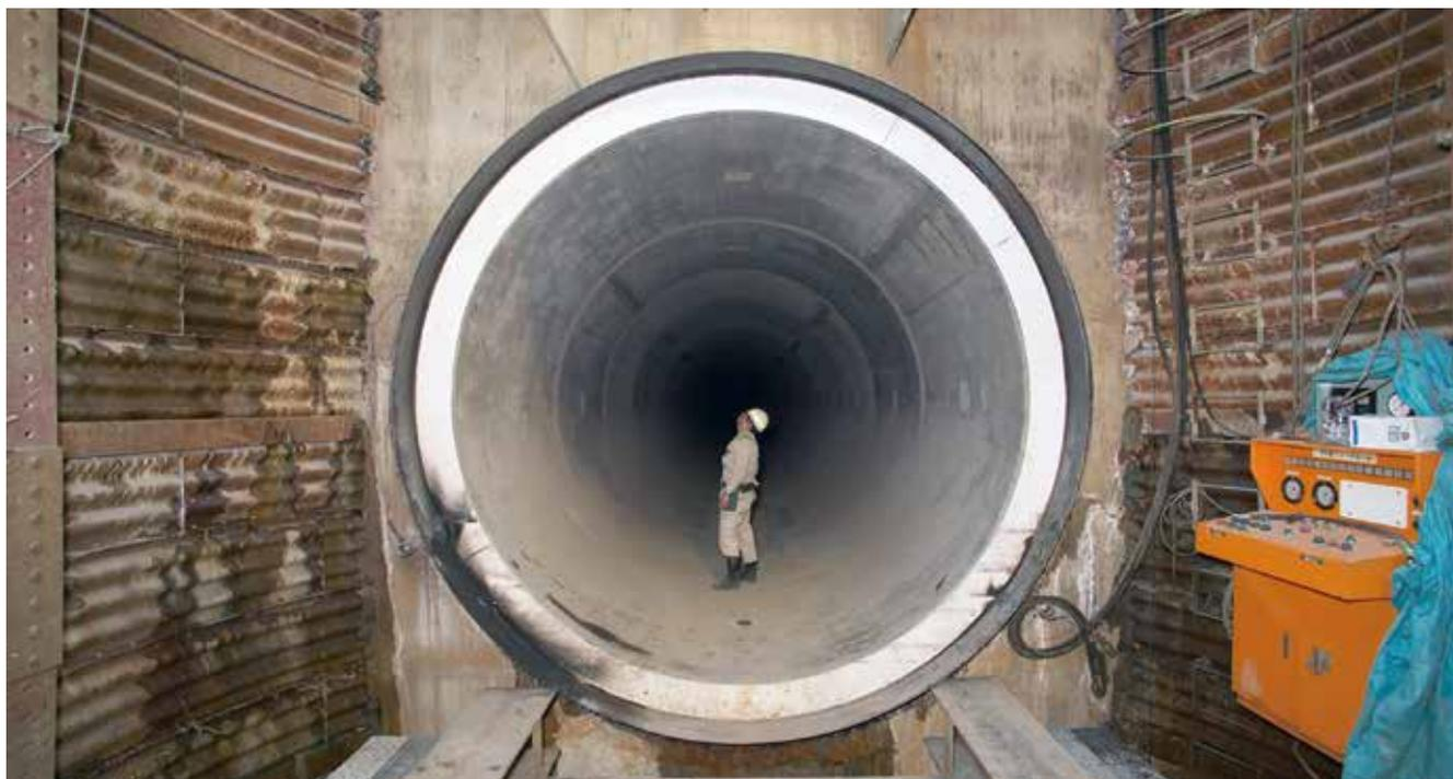
写真-2 超大口径推進管
