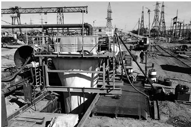
発電タービンから冷却水を排出する2条配管のうちの本が、現場硬化管（CIPP）により更生された。この鋼管の径は $\phi$ 1,220mmから $\phi$ 2,220mmの範囲で、短いテーパー部を介して口径が変化している。タービンの稼働状況により、自然流下管（水位半分）としても、圧力管としても機能する。60年以上経過した管路であり、部分的にプラントの地上設備の下に敷設されている。
