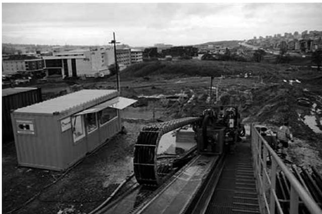
Ekol Yapi Insaat社では天然ガスパイプライン（鋼管、 $\phi$ 約910mm）の敷設を行うためHDD工法を採用した。イスタンブールでのプロジェクトは、2つの主要道路横断を含み、トルコでのHDDの最長記録（施工延長：487m, 847m）となるもので、施工では多くの課題（難しい地形・土質条件、重要構造物（上部、下部）への近接施工等）に直面した。
