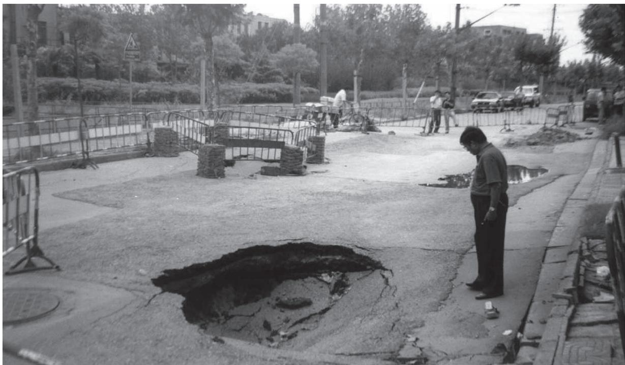
写真一3 パイプの損傷による道路陥没現場
