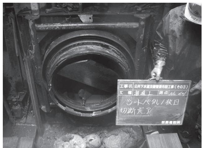
写真-1 回収した刃先と鋼矢板
