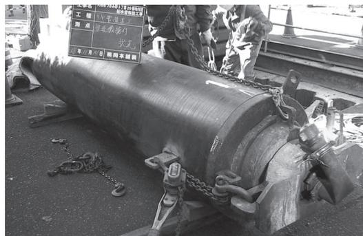
②グルンドラム工法【空圧式推進工法】
