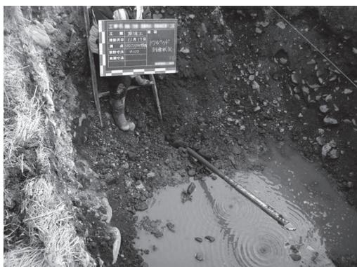
写真-4 パイロット削孔完了：上部は礫・玉石層であった
