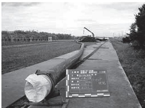
写真-3 PE管延管状況
