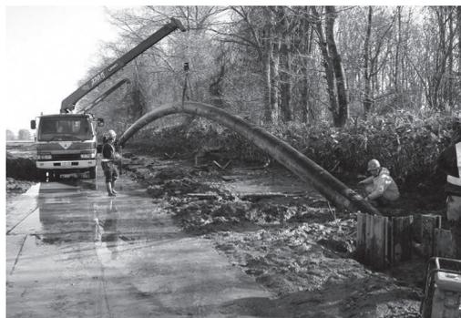
写真-5 φ450PE管引込状況
