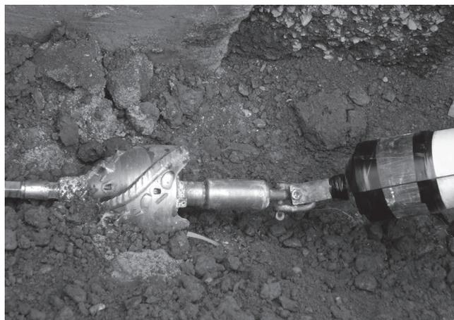
写真-1 バックリーマ及び埋設管
